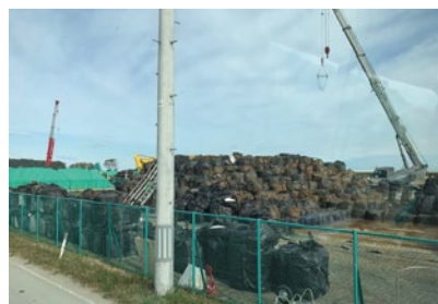
津波被災地域に並ぶ除染仮置き場は搬出が進んでいる。
