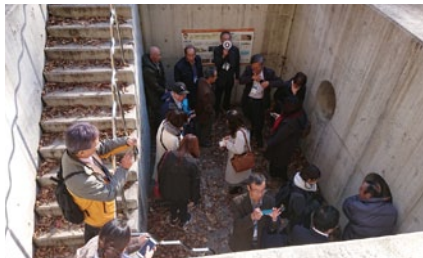
小水力発電所施設
