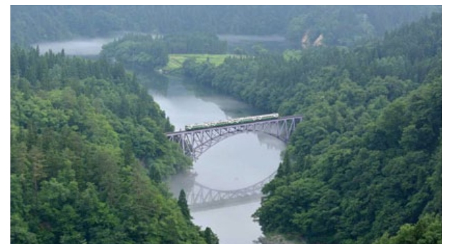
只見線第一橋梁
