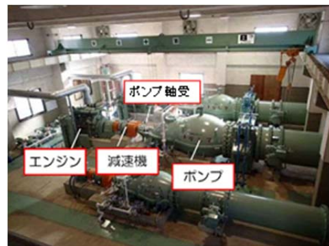
図3 ポンプ機器概要(排水機場の例)
