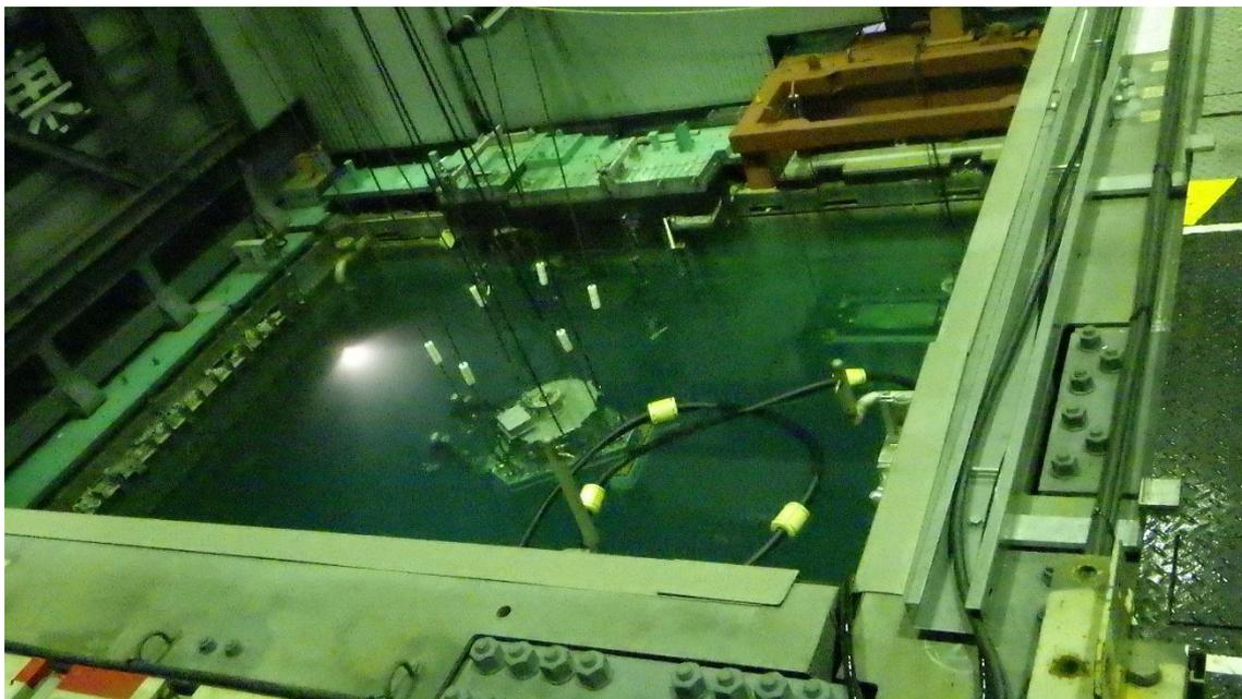
③ 3号機原子炉建屋オペレーティングフロアでの確認状況。専門委員が燃料取扱機／クレーン不具合対策として実施されたケーブル交換箇所等の確認している様子。
