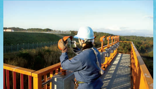
航空灯火の点検
