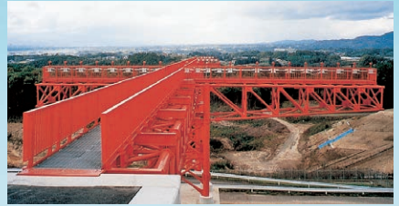
簡易式進入灯 (SALS) 非精密進入によって着陸しようとする航空機に、その最終進入の経路を示すための灯火です。L=153m
