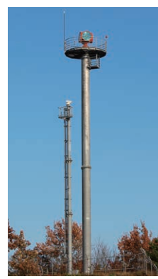
飛行場灯台 (ABN) 飛行中の航空機に飛行場の位置を示すための灯火です。
