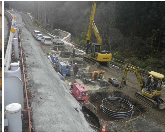
アースシェッド基礎工(深礎杭)施工状況
