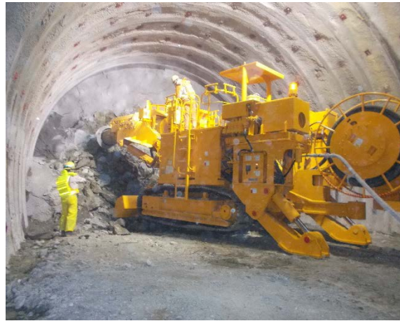
トンネル掘削状況(機械掘削)
