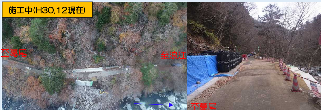
崩落した巨大な石を除去し、数年ぶりに道路の形が現れました
