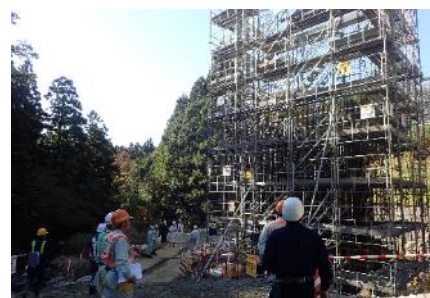
橋脚を安全に作るための足場工の状況
