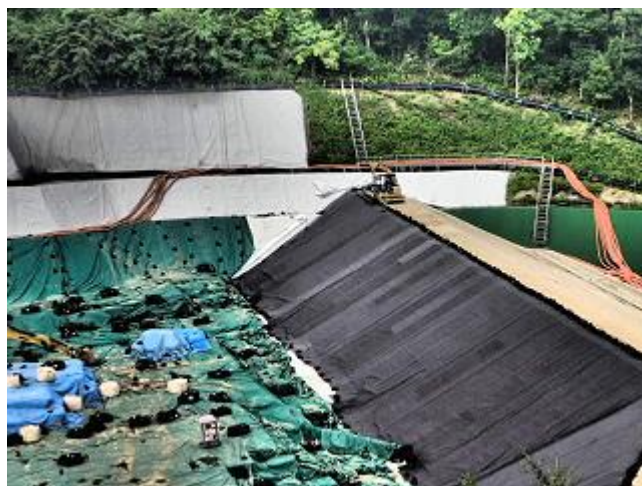
土堰堤の築堤状況の確認
