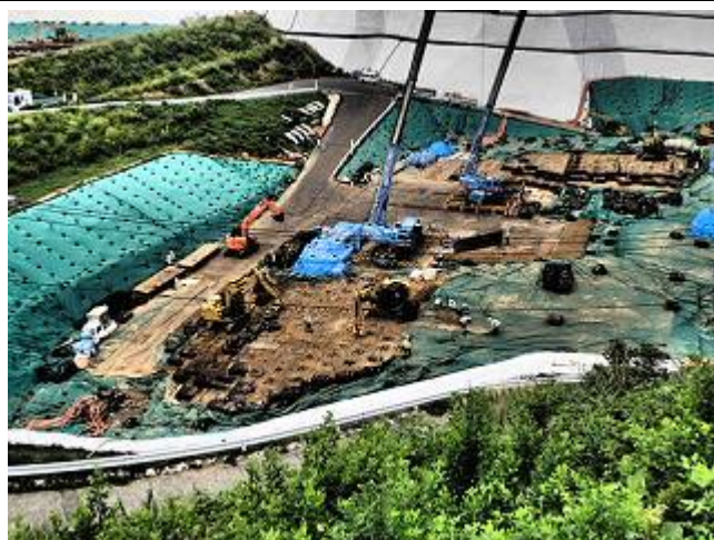
下流側埋立地の埋立状況の確認
