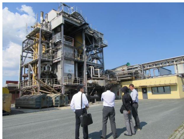
【木質バイオマス発電施設】
