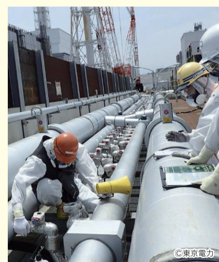
今回は、埋設物が多く、排水管やケーブルなど壊せないものやその他の埋設物もあったので、凍結工法でこそ対応可能だったのかなと思っています。
