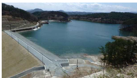
試験湛水状況 (H29. 4. 19)
