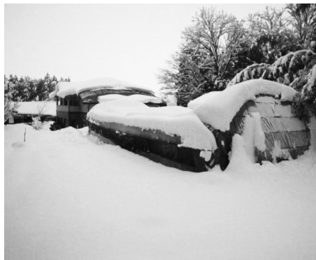
降雪で倒壊したパイプハウス
