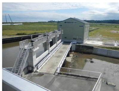
八沢浦排水機場の復旧状況
