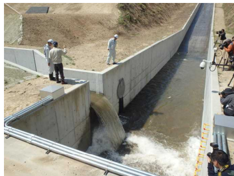
供給再開状況 (H29. 4. 24)
