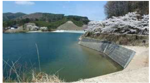
藤沼ダムの湛水状況（須賀川市）
