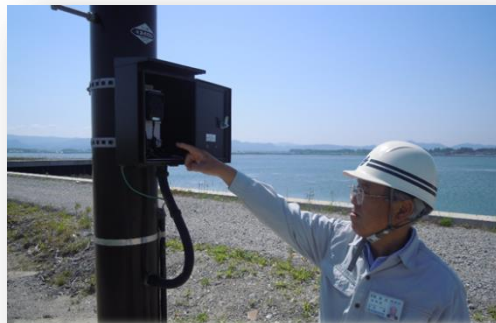
相馬市防災行政無線子局増設工事
