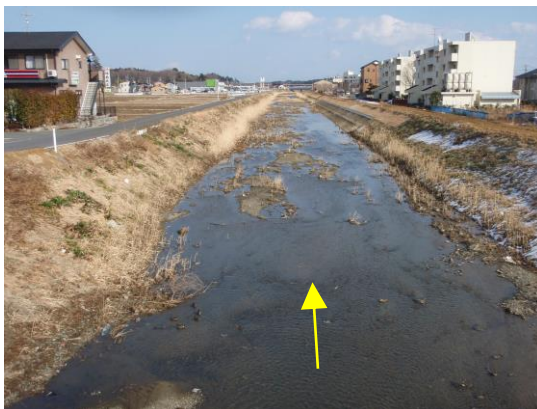
写真－3 小泉川下流部（国道6号沖ノ内橋下流）
