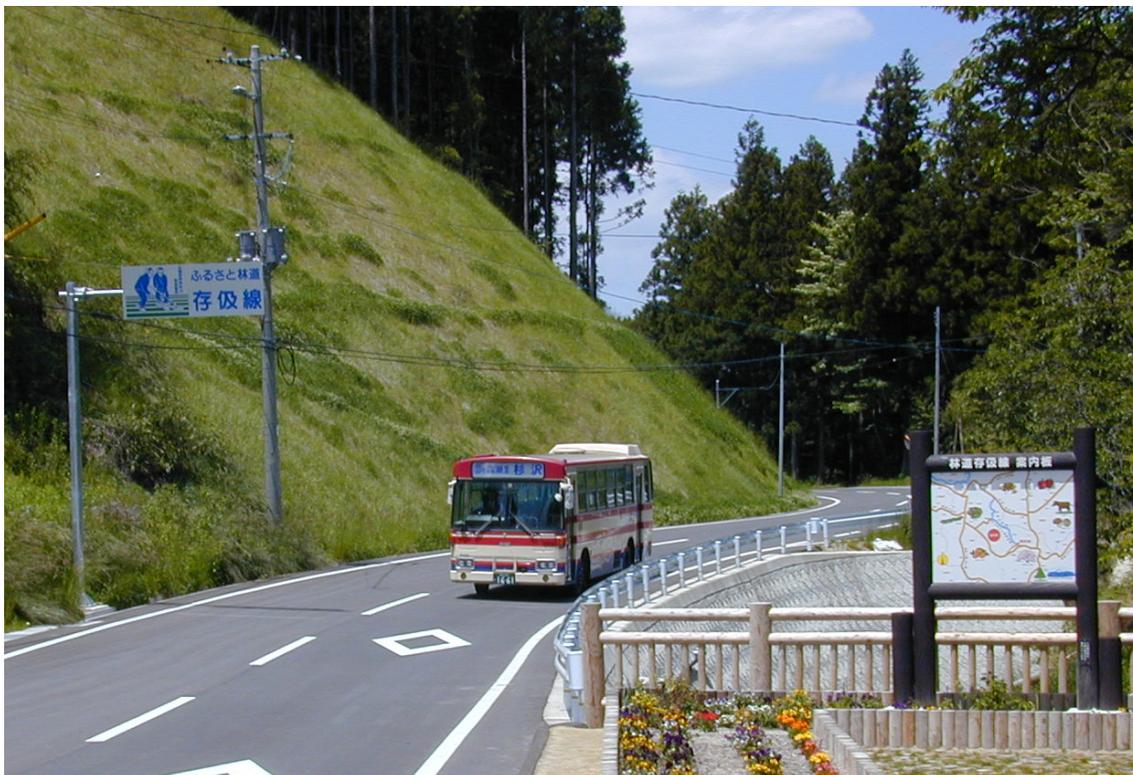
二本松市西部（旧岩代町の中央部）に位置し、同市内の長折地区と西新殿地区を結ぶ全延長 7,170m 利用区域 280ha の森林整備を目的として開設された林道である。また、沿線には人家 188 戸、集会所等公共施設、農地が存在し、長折・上太田・西新殿の 3 集落間を結び、定期路線バス・スクールバスが走る生活に密着した林道でもある。当路線は、災害時における国道 459 号線の代替ルートとして位置付けられ、ふるさと林道緊急整備事業により、全幅員 5.0m から 7.0m の 2 車線で整備されています。
