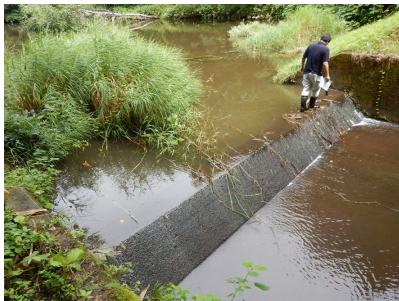
ため池緊急点検の様子
