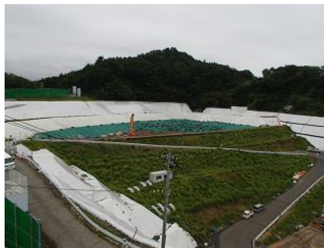
上流側埋立地の埋立状況の確認
