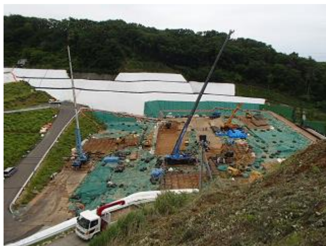
下流側埋立地の埋立状況の確認
