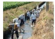
水路の泥上げ
