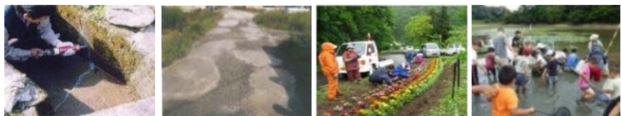
水路のひび割れ補修 農道の窪みの補修 植栽活動 ため池の外来種駆除
