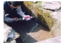
水路のひび割れ補修
