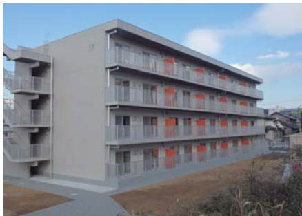
安積団地17号棟
