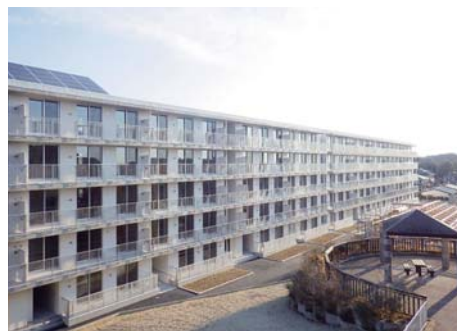
湯長谷団地24号棟
