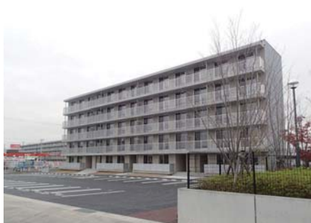
東原団地2号棟
