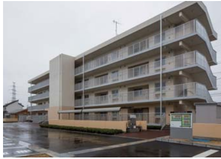
北中央団地1号棟
