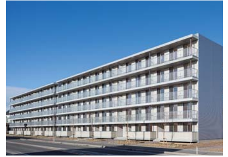
東原団地1号棟
