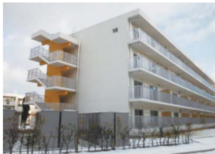
安積団地18号棟
