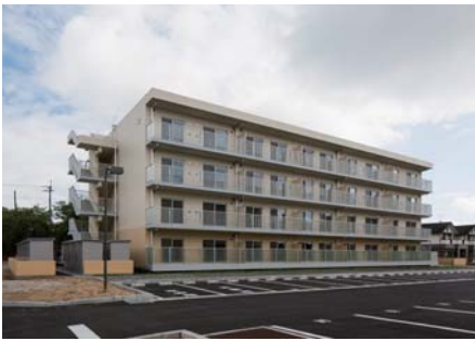
北中央団地3号棟
