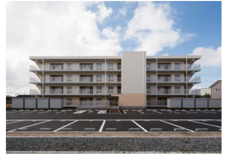
北中央団地2号棟
