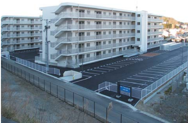
●1月21日にいわき市内では初となる復興公営住宅が完成 1月27日には鍵引渡式を開催
