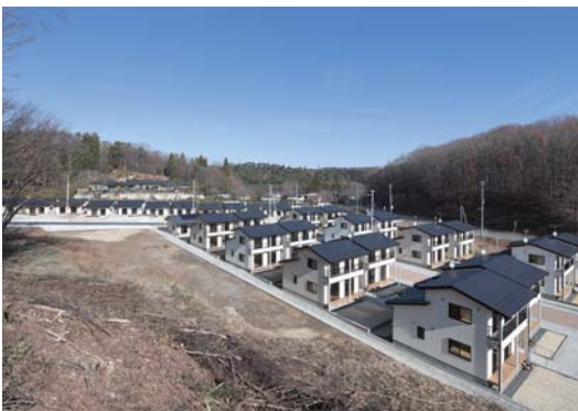
●11月29日、白河市内では初となる復興公営住宅が完成するとともに全ての整備(2団地)が完了
