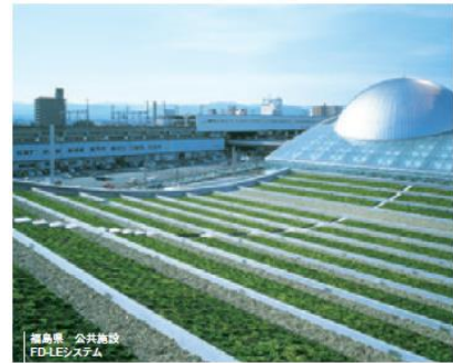
図 2-1-17 屋上緑化の事例
