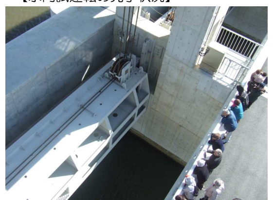
【水門試運転の見学状況】
