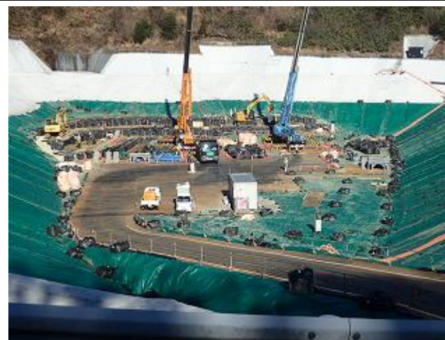
上流側埋立地の埋立状況の確認
