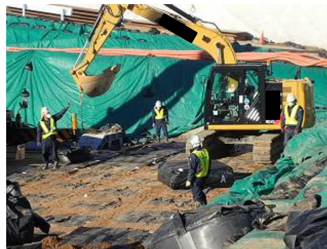
下流側埋立地の埋立状況の確認
