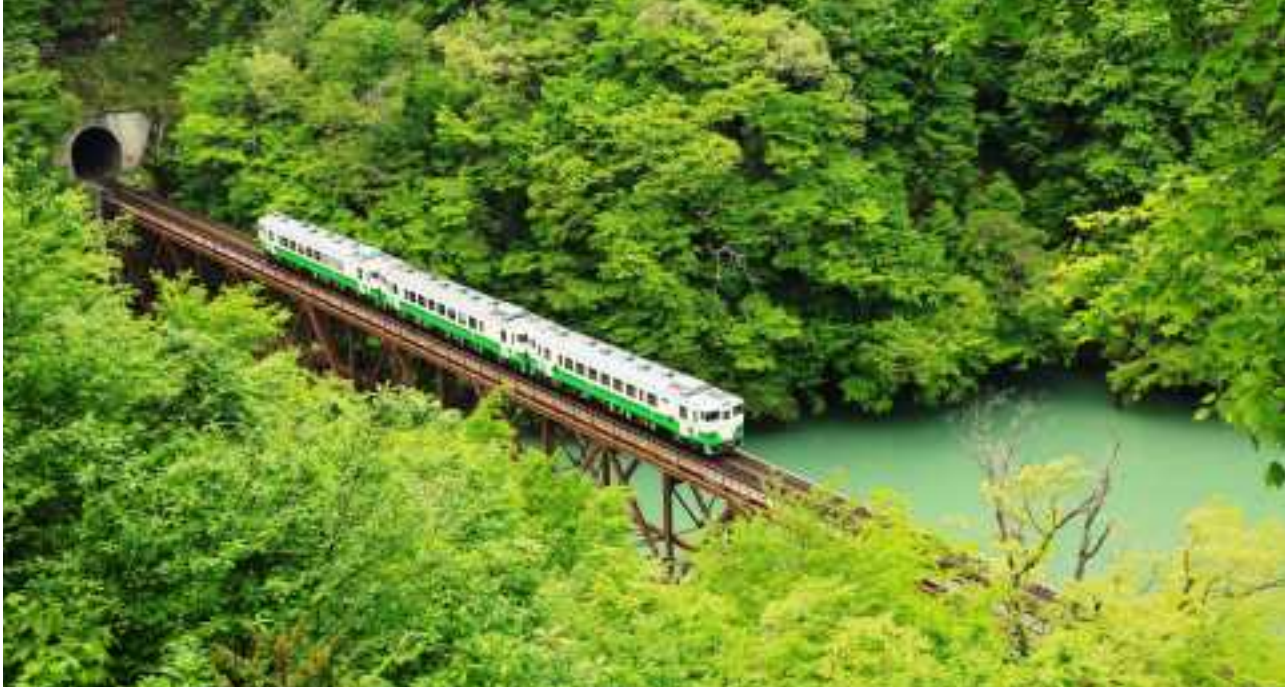
第三只見川橋りょう(三島町)
