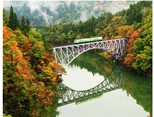
秋の第一只見川橋りょう(三島町)
