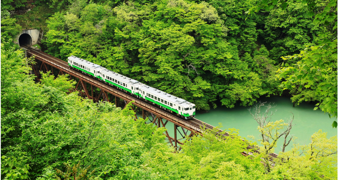
第三只見川橋りょう(三島町)
