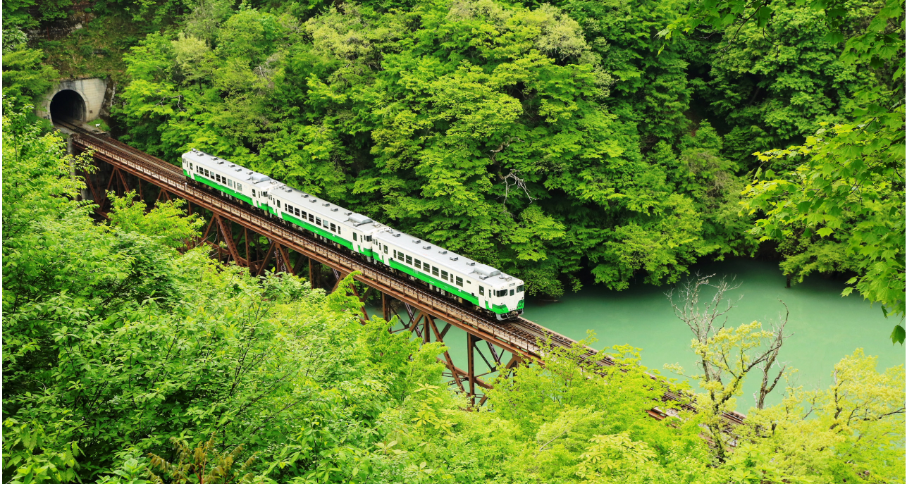
第三只見川橋りょう(三島町)
