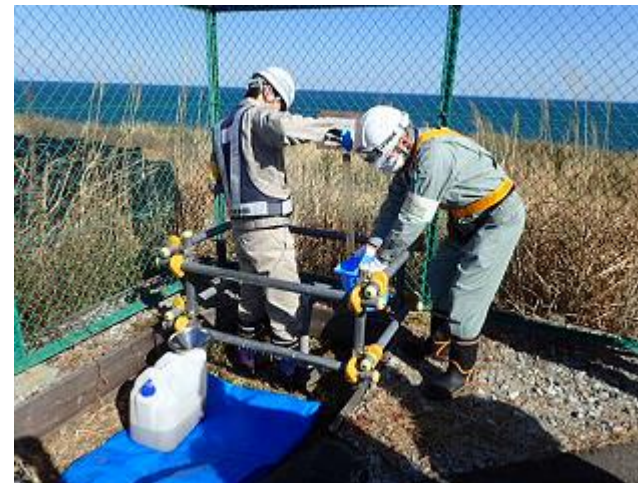
大熊工区保管場における地下水の測定
