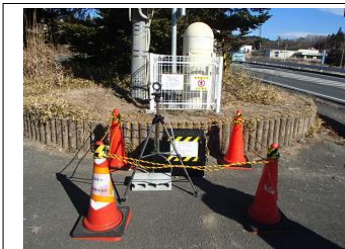
敷地境界における大気浮遊じんの測定
