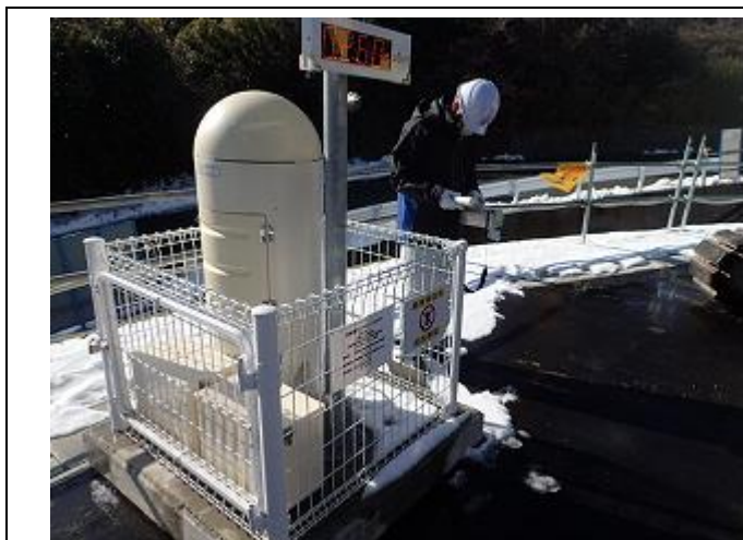
土壌貯蔵施設のモニタリングポストの確認
