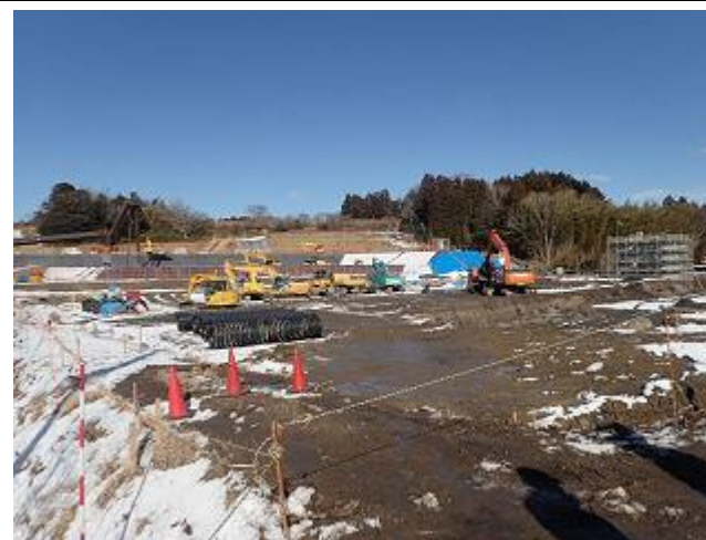
土壌貯蔵施設の整備状況の確認
