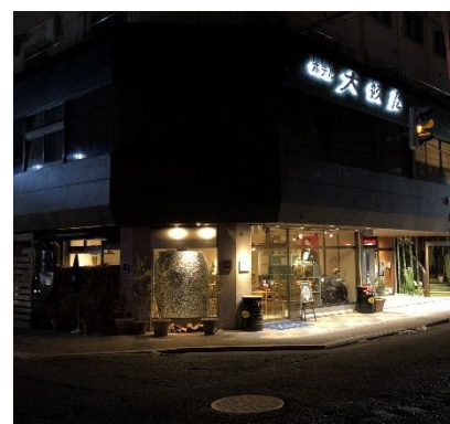
新規文字看板／2階バルコニー部
