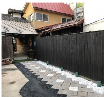
新規インターロッキング／アプローチ
