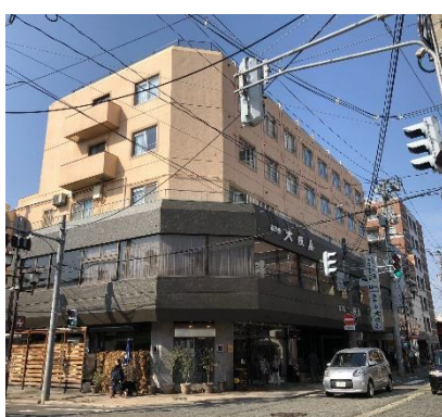
塗装後／2階バルコニー部
