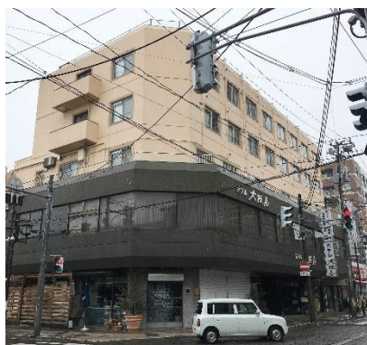
塗装前／2階バルコニー部
