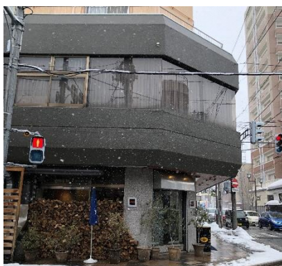
塗装後／2階バルコニー部
