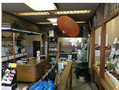
既存天井照明、床材／店内
