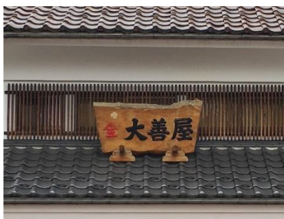
既存看板／外観
