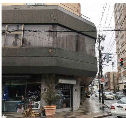
塗装前／2階バルコニー部
