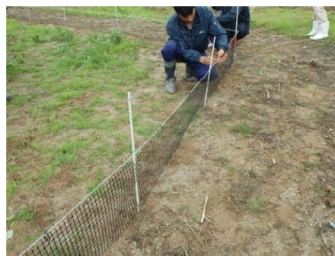
図2 併用柵の設置作業
