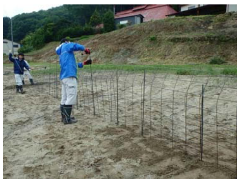
図1 ワイヤーマッシュ柵の設置作業
