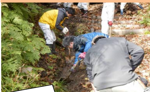
今年度の補修作業の様子（洞門前広場）
