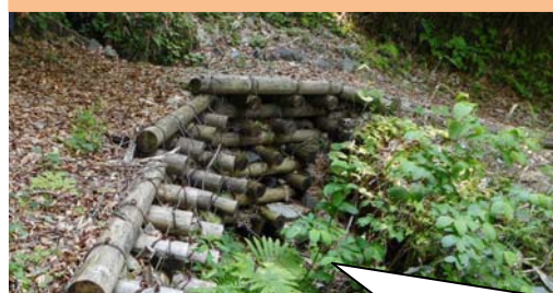
丸太を組み上げて施工した丸太土留工
