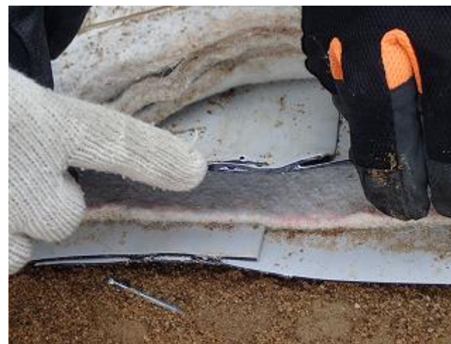
遮水シートの施工状況の確認
