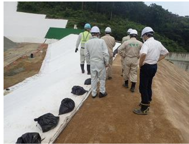
土堰堤の施工状況の確認
