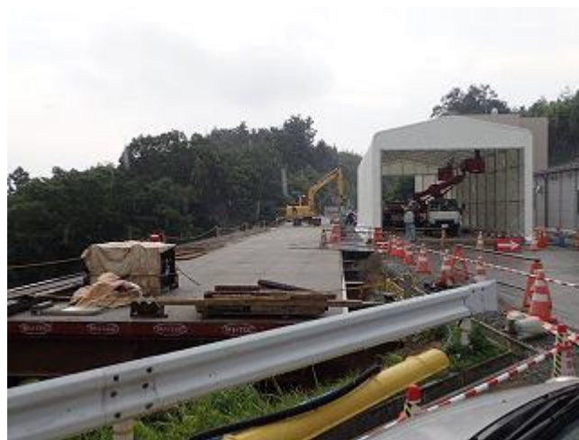
テント設置及び通路拡幅工事の確認
