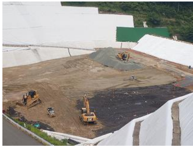
下流側埋立地の埋立直しの状況の確認
