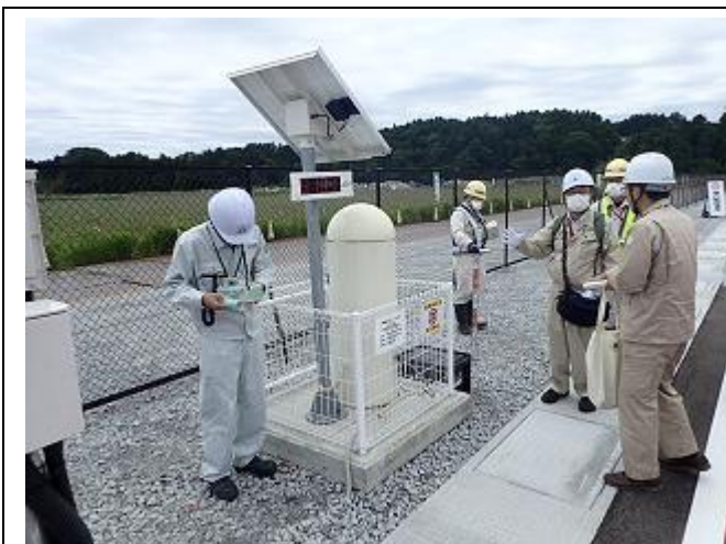
モニタリングポストの設置状況の確認
