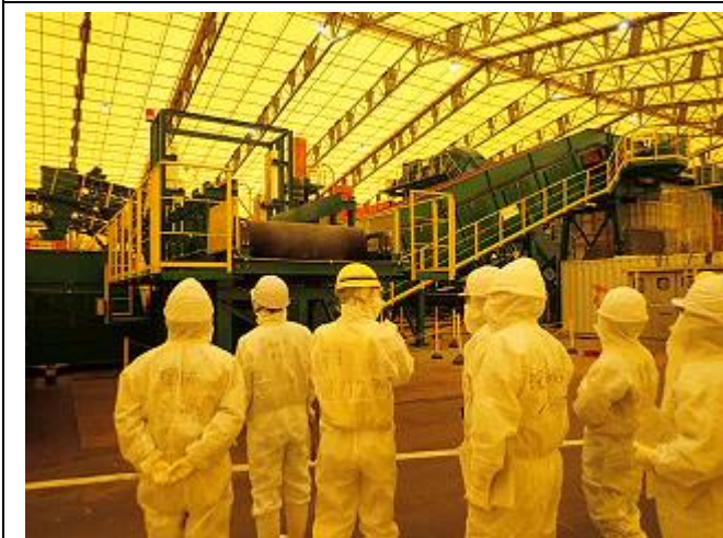
受入・分別施設の設備等の確認
