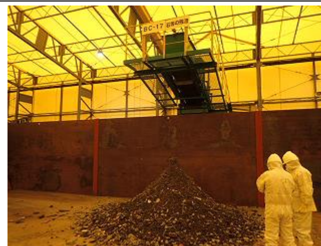
汚染土壌の分別状況の確認
