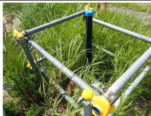
保管場のモニタリング井戸設置状況の確認
