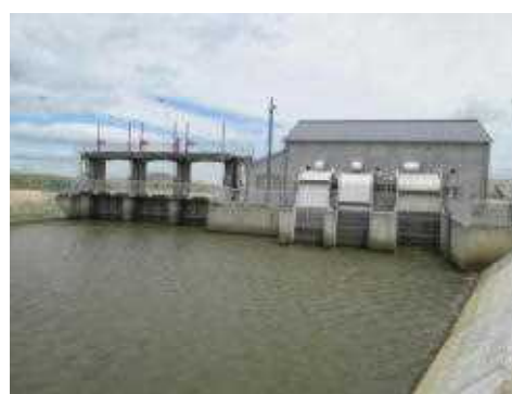
排水機場の復旧状況
