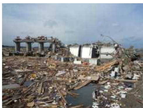
排水機場の被災状況
