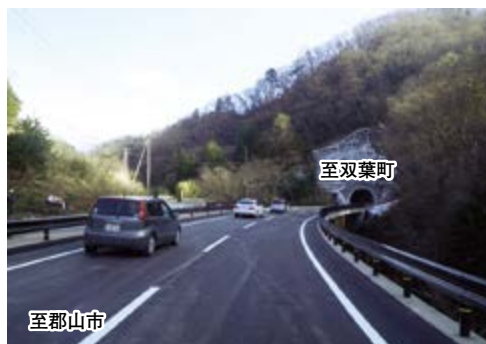
国道288号玉ノ湯工区 (平成26年12月25日開通)
