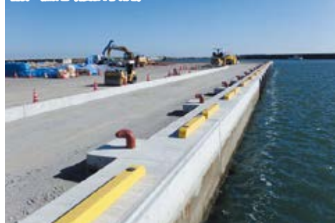
請戸漁港(復旧状況)
