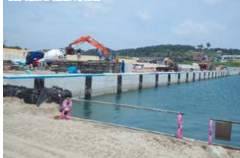
富岡漁港(復旧状況)
