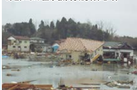
津波による住家被災状況(新地町)
