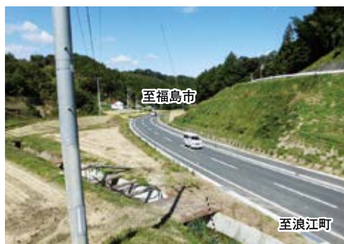
国道114号小綱木バイパス (平成27年6月28日開通)
