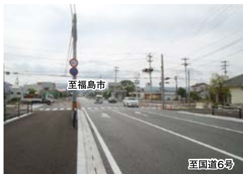
国道114号浪江拡幅1工区 (平成27年9月29日開通)
