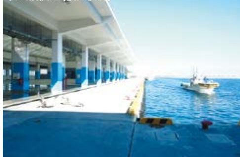
松川浦漁港(復旧状況)
