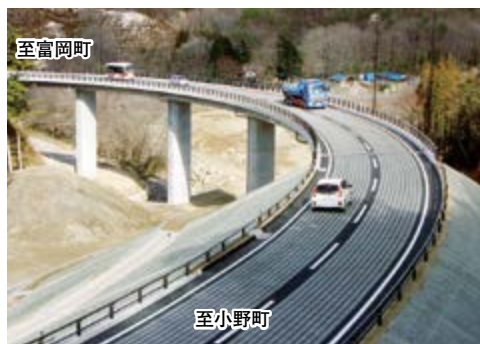
県道小野富岡線吉間田工区 (平成27年3月24日開通)
