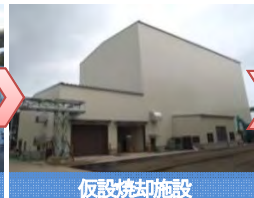
仮設焼却施設
