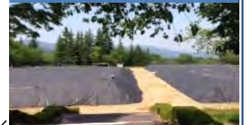
仮置場の状況
