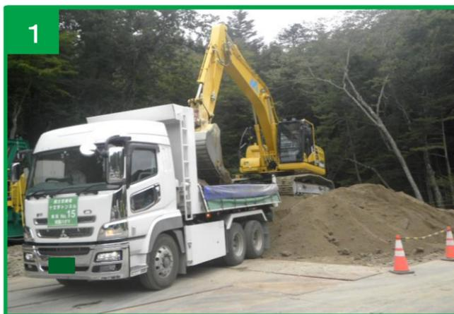
工事現場の仮置場でのズリ積込み状況
