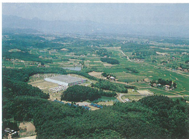
緑に囲まれた工場
