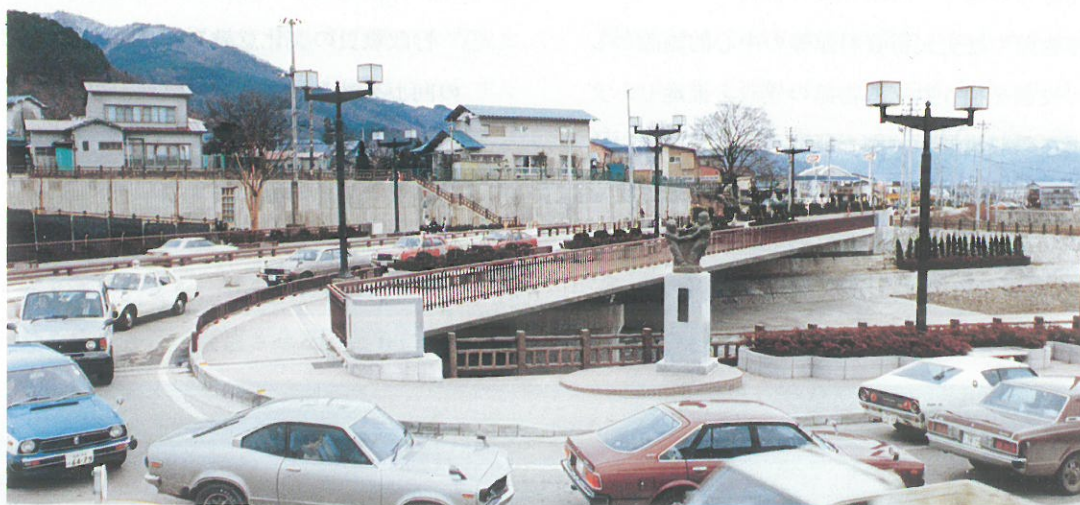
文化のための1%システム推進事業により整備された小田橋（会津若松市）
