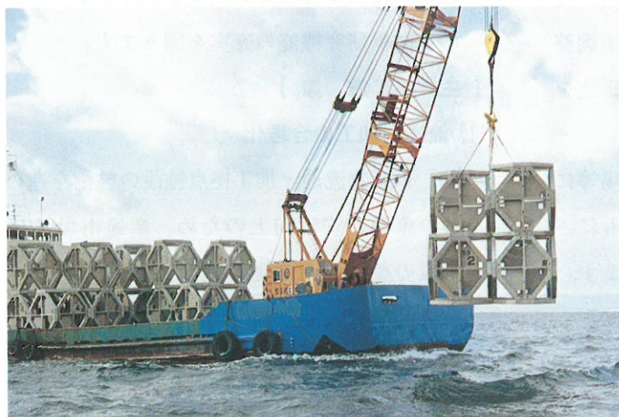
人工礁の沈設
