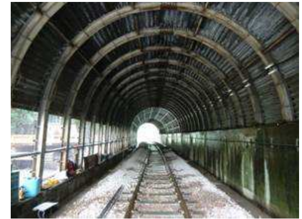
89k820m付近(第1赤沢雪覆い工) (施工後)
