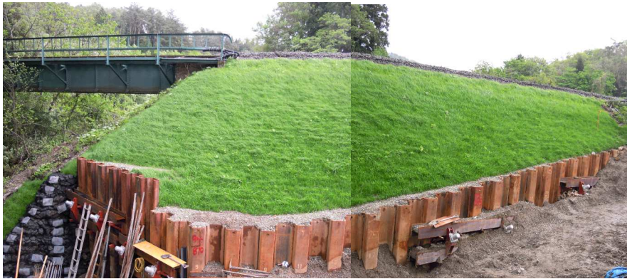
30k700m付近 盛土復旧(施工後)
