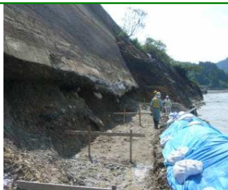
59k910m、60k450m付近 護岸壁洗掘
