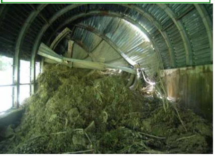
89k700m付近、89k820m付近 土砂流入
