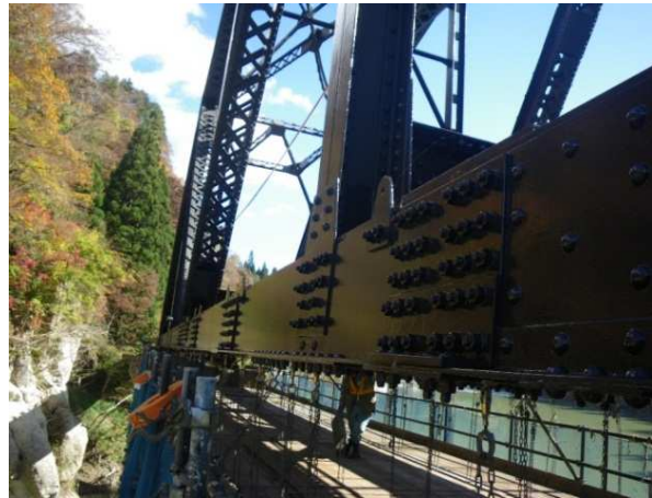
第4只見川橋りょう(施工後)
