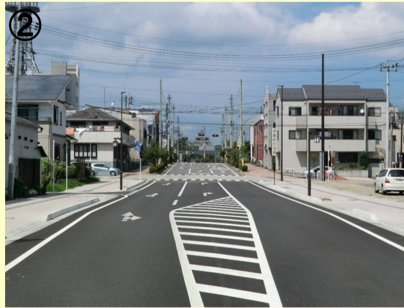
② 路線名 : (都)白河駅白坂線 事業名 : 街路事業 場所 : 白河市大工町・向新蔵地内 工事説明 : 「白河の顔となるシンボルロード」を形成する道路として、安全安心な歩行空間を確保することで、地域の歴史を生かしたまちなか観光を確立しながら、中心市街地の活性化に寄与します。
