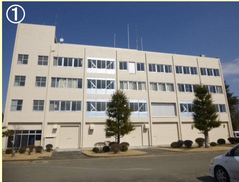
① 路線名 : 太陽の国 事業名 : 太陽の国管理センター耐震改修事業 場所 : 西白河郡西郷村大字小田倉地内 工事説明 : 耐震性能診断Cランクである管理センター棟建物の耐震補強のほか、最新の耐震設計・施工指針に拠る昇降機更新により、耐震性能を向上し、安全で良好な執務環境を提供します。
