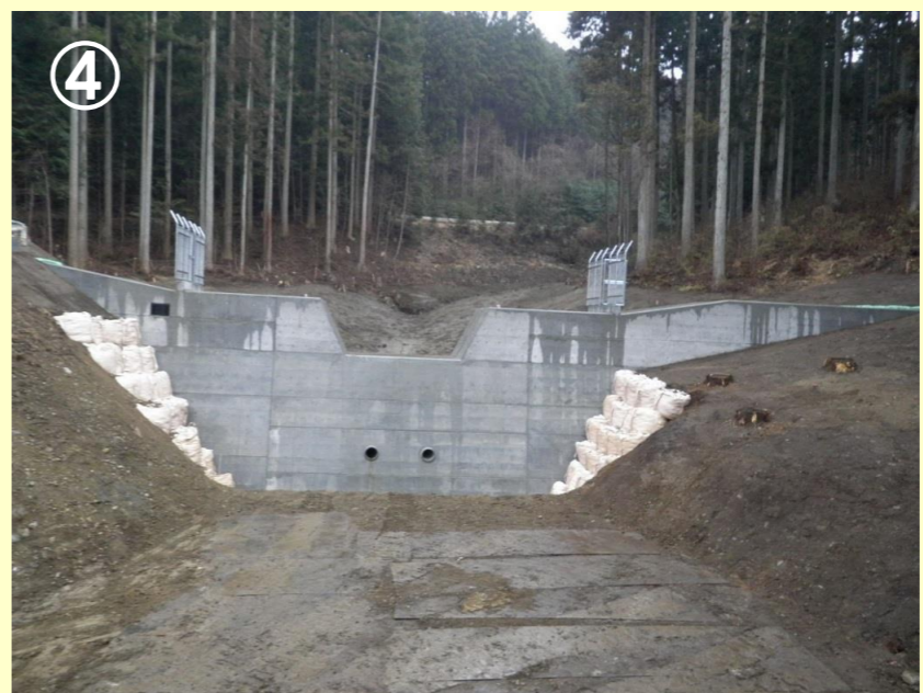
河川名：ボンケラノ沢 事業名：交付金事業 場所：東白川郡棚倉町大字大梅地内 工事説明：土石流による土砂災害を防止するため、砂防えん堤工の施工を進めています。
