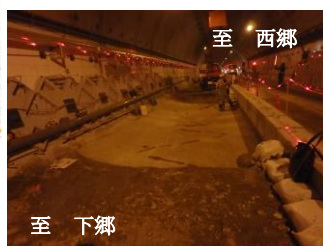
既設インバートコンクリート状況
