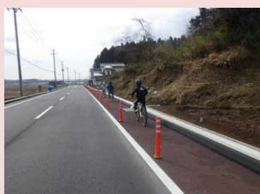
須賀川矢吹線 天開工区 （矢吹町）
