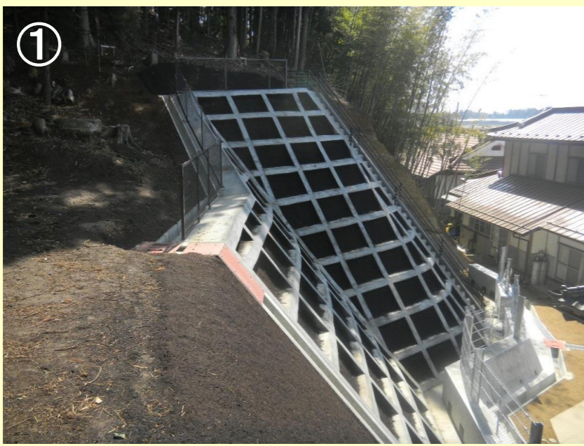
① 箇所名：平鉢2号 事業名：交付金事業 場所：西白河郡矢吹町平鉢地内 工事説明：斜面崩壊等の危険性が懸念されるため、対策工事を実施し、下部の人家群を保全します。
