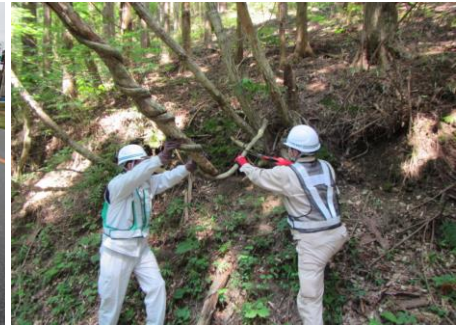
支障木撤去作業
