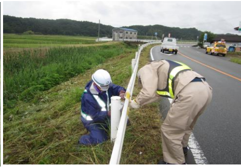
応急補修作業
