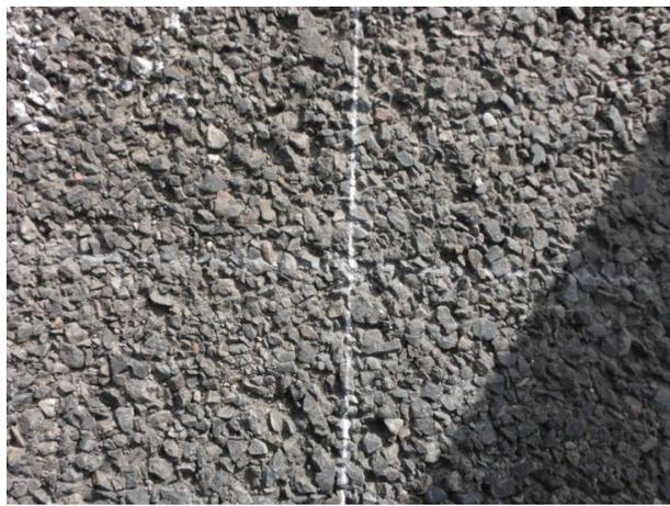
写真3 既存技術による作業後の舗装表面(A)
