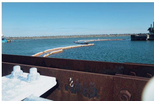
図 復旧後の1～4号機側 シルトフェンス（H28.11.25撮影）
