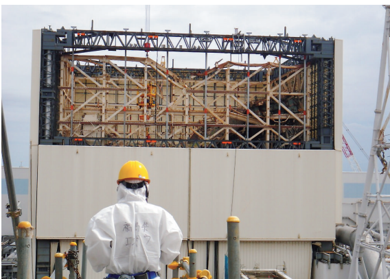
1号機原子炉建屋カバー壁パネル取外し状況確認
