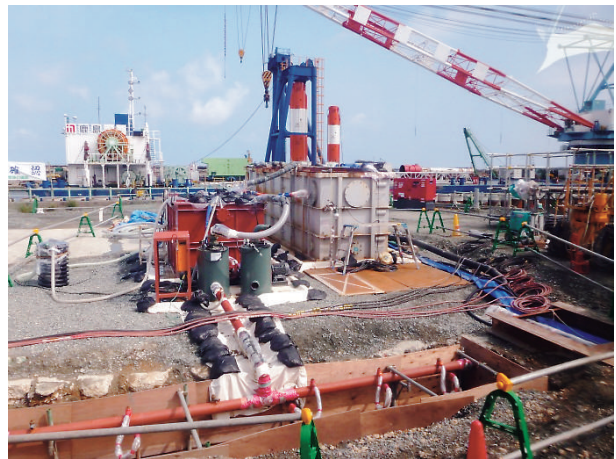
ウェルポイントによる汚染地下水汲み上げ
