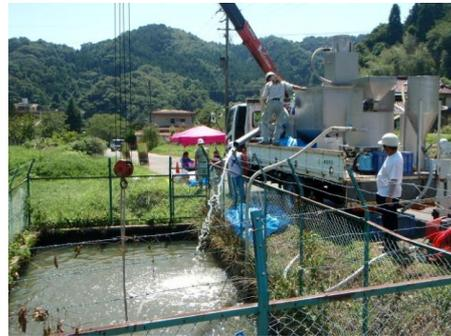
写真2 防火水槽水の循環処理
