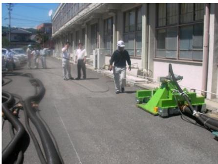
写真3 アスファルト路面の除染
