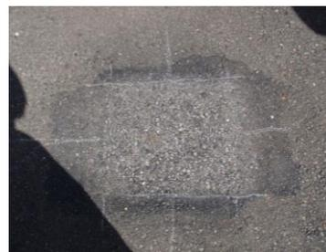
写真6 除染後のアスファルト舗装
