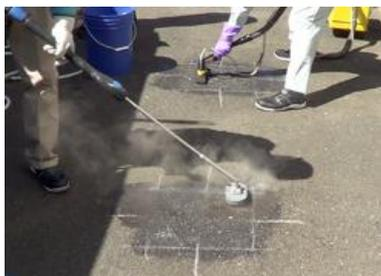
写真5 駐車場舗装面の洗浄作業
