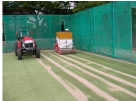
写真4 砂充填機械による砂入れ作業
