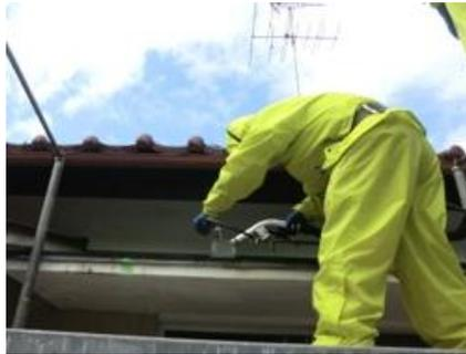
写真4 トタンひさしの除染
