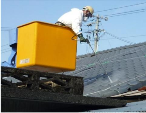
写真1 塗り瓦試験における屋根の洗浄
