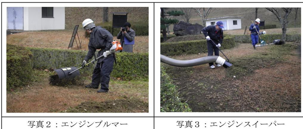
イ) インターロッキング：5%重層水で高圧洗浄し、目地の汚れを浮かせてから、エンジブルマーでブラッシングを行う。
