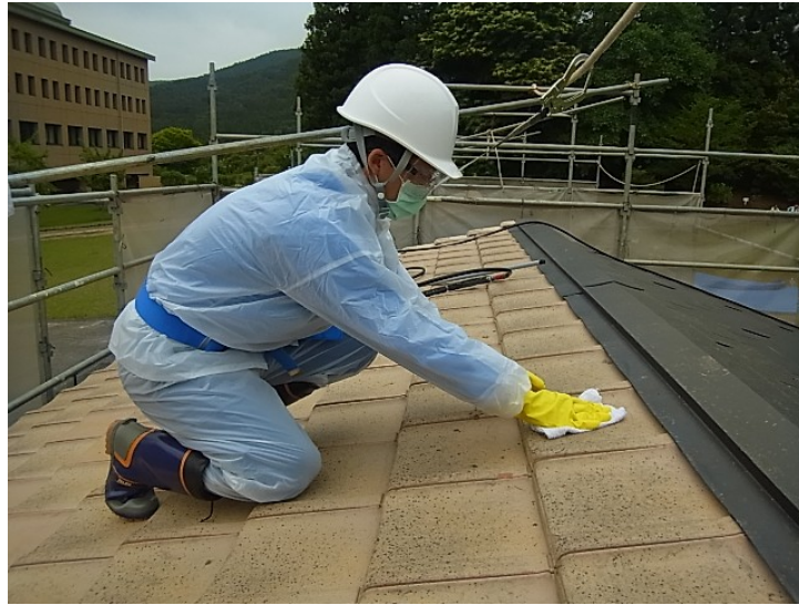
屋根除染の例（拭き取り）
