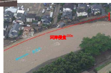
河岸侵食に伴う家屋倒壊等
