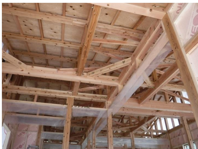
柱・梁・屋根等が組み上がりました。
