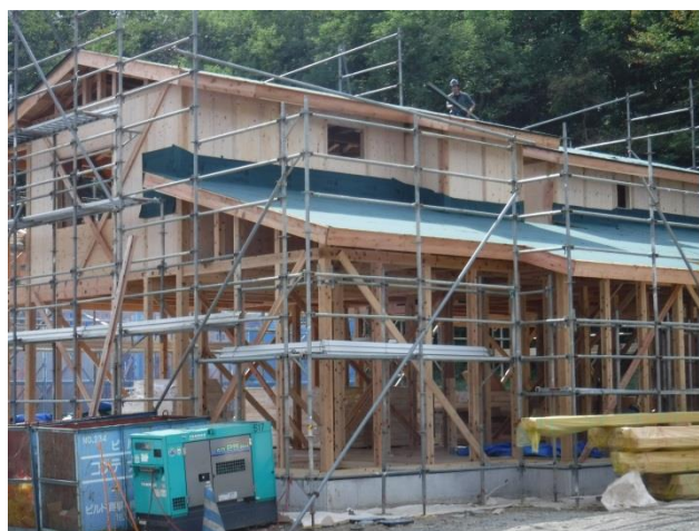
2階建住棟（3LDK） 壁パネルを設置すると共に、屋根を施工中です。
