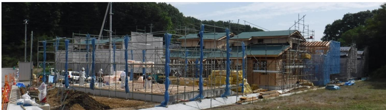
敷地南側 2階建住棟
