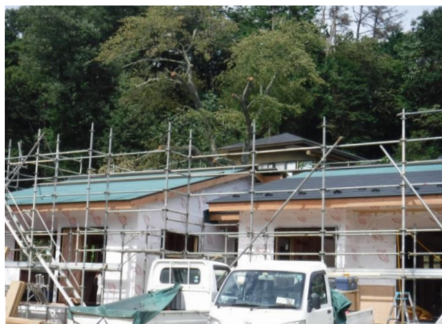
平屋建住棟（2LDK） 壁を設置し、屋根を施工中です。 窓のサッシ枠を入れました。
