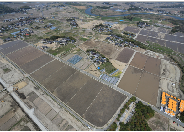
進む！大区画ほ場整備：夏井地区（いわき市）
