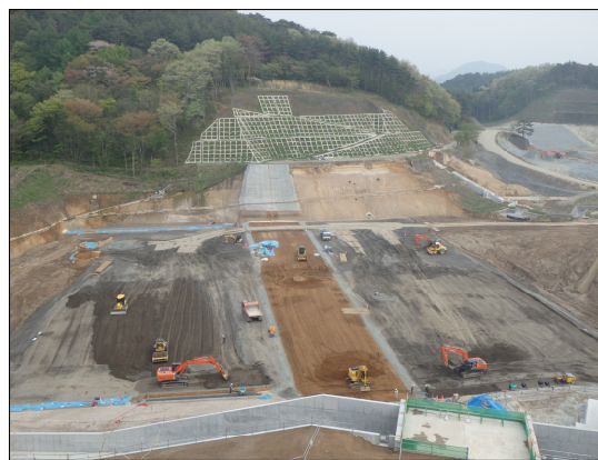
本堤盛立工進捗状況 (H28.5月)
