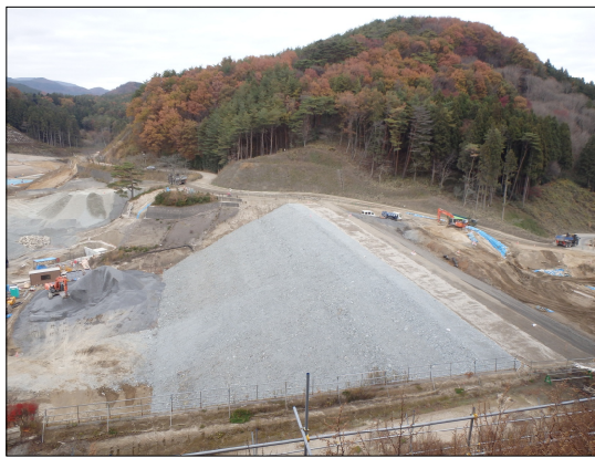
副堤盛立工完了 (H27.10月)
